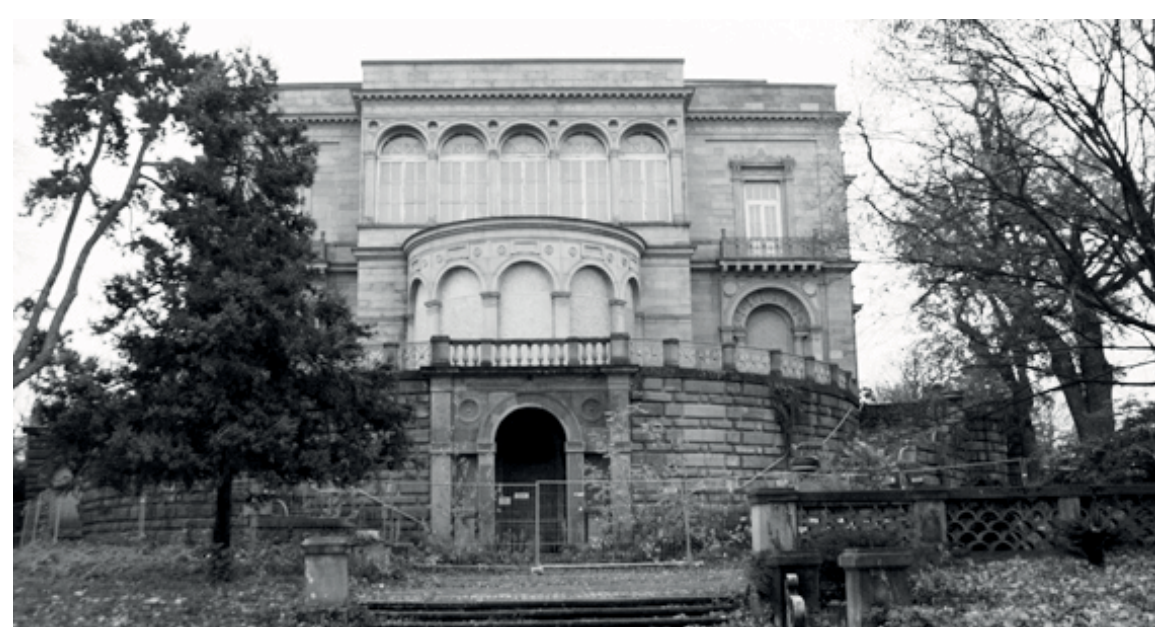
Die Villa ist das erste Neorenaissancegebäude in Stuttgart und wurde nach der Zerstörung im zweiten Weltkrieg 1951 auf die damals aktuelle Art und Weise umgebaut. Dabei gingen die wichtigsten architektonischen Elemente des Gesamtkonzepts wie Ecktürme, Glasdach und Nordflügel - verloren.
